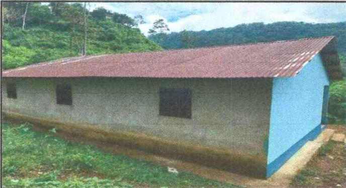
Foto 1: Se puede observar la parte de atrás del Centro Educativo en donde se evidencia el oxido por deterioro de las laminas.
