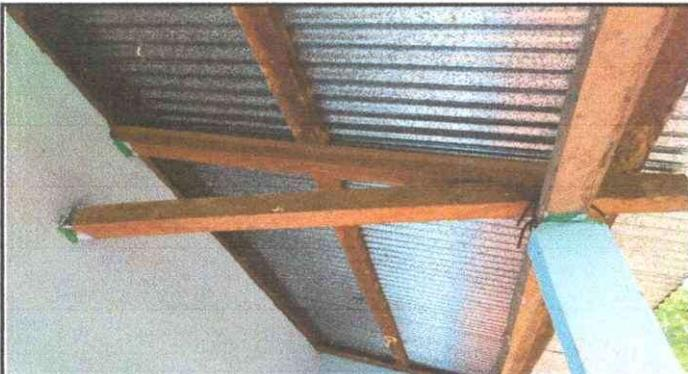
Foto 3: Se observa parte de la estructura de madera en donde se logra ver el desgaste de la madera por la polilla.
